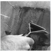
Aplique líquido limpiador a la capa hermética en la zona de la perforación. Use un raspador inmediatamente, para remover cualquier sustancia contaminante.
