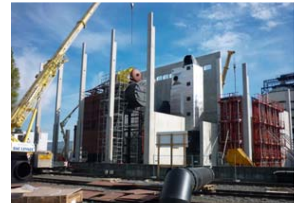
Construction d'une chaudière à bois sur le site de Cholet (France).
