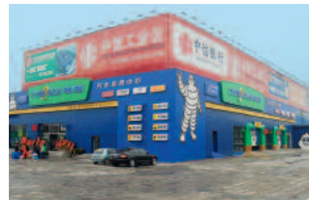
400 TyrePlus en Chine en 2007 et 100 ouvertures de nouveaux centres de distribution et de services prévues en 2008.
