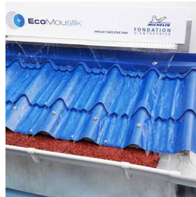
Pose de l'AGLOSTIC® dans les gouttières
