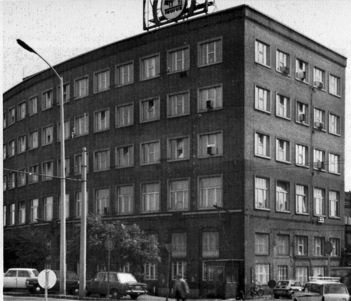
A háború előtt épült Kerepesi úti épület az emeletréépítés után, ma
