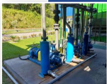
Redução do descarte de água de selagem de bombas de vácuo, gerando economia de cerca de **1.130 MWh PCI/ano** e **202t CO2/ano** e uma redução do consumo de água em **15.500m3/ano**.
